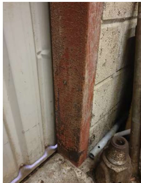
Fig. 1: Ejemplo de corrosión inducida por sal en una superficie de acero.
