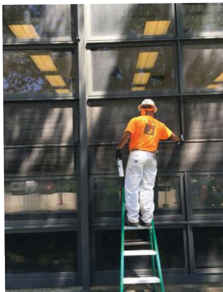
Imagen: La solución consistió en lavar a presión todo antes de pintar para eliminar el polvo y otros contaminantes solubles en agua, y lijar (con máquina o a mano) todas las áreas cubiertas con aceite de silicona. El aceite de silicona siempre estuvo adyacente a las dimensiones exteriores de las ventanas.
