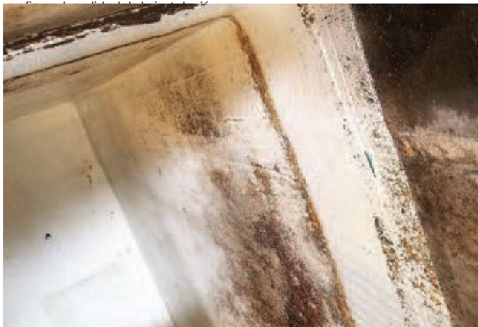
FIG. 7: El uso de un color blanco contrastante para la capa superior en las cuencas restauradas del JBWRF permite realizar controles visuales fáciles del estado del recubrimiento, ya que cualquier área verde (como el punto que se muestra cerca de la parte superior del área revestida aquí) indica daño.
