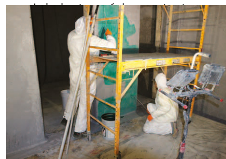
FIG. 3: Los aplicadores utilizaron rodillos de fibra de vidrio de aluminio para trabajar el material laminado teñido de verde en la alfombra para asegurar una humectación completa y una adhesión adecuada.
