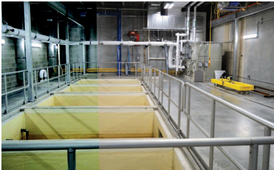
FIG. 5: En la GFRWTP, los aplicadores instalaron un sistema de recubrimiento de poliuretano flexible en cinco cuencas de biorreactores de membrana recientemente instaladas, lo que llevó de uno a dos días por cuenca.
