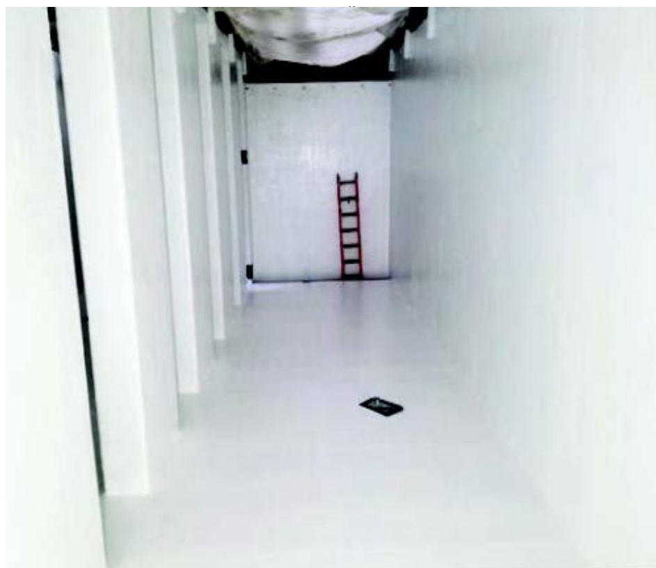
FIG. 4: El recubrimiento de amina epoxi de ultra alto contenido de sólidos utilizado como capa final para los revestimientos de cuencas MBR JBWRF está diseñado para servicio de inmersión y presenta propiedades de alto espesor y retención de bordes para una protección superior.
