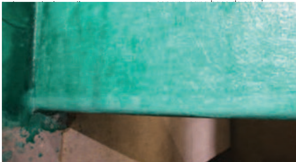
FIG. 6: El uso de un endurecedor de color verde con un laminado transparente para revestir los depósitos de MBR JBWRF facilitó la humectación completa de la estera de fibra de vidrio durante las aplicaciones.
