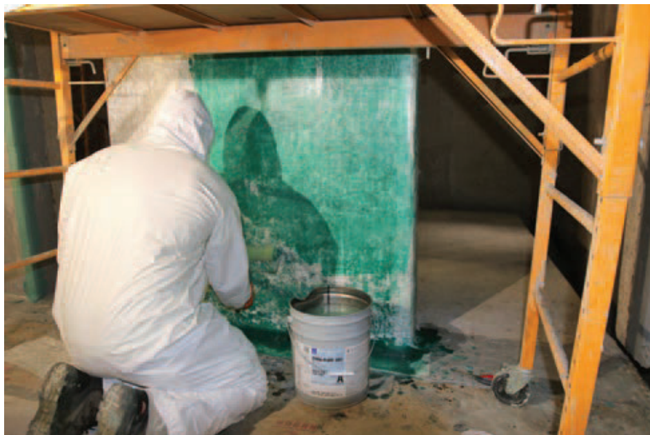
FIG. 2: La aplicación de la capa de refuerzo para los depósitos MBR JBWRF implicó sellar una estera de fibra de vidrio de 1,5 onzas usando un laminado epóxico teñido de verde.
