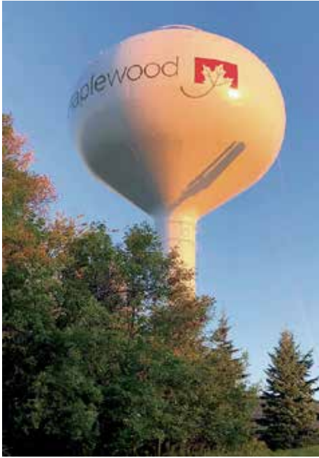
FIG. 1: SPRWS seleccionó un sistema de recubrimiento de 100 % sólidos recientemente aprobado por NSF/ANSI/CAN 600 para su torre de agua Sterling Avenue de 500 000 galones que ayudó a que el tanque restaurado pasara una prueba de sabor discriminatoria del panel de agua en el primer intento.
