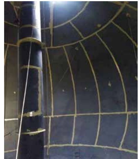
FIG. 3: Los aplicadores granallaron el interior de la torre hasta alcanzar un estándar de metal casi blanco, aplicaron una imprimación de zinc a todo el interior y, a continuación, aplicaron una capa de recubrimiento en franjas a las costuras de soldadura y los bordes para asegurar una cobertura completa de estas áreas difíciles de recubrir. A continuación, se aplicó una capa completa de recubrimiento reforzado con escamas de vidrio, 100 % sólido.
