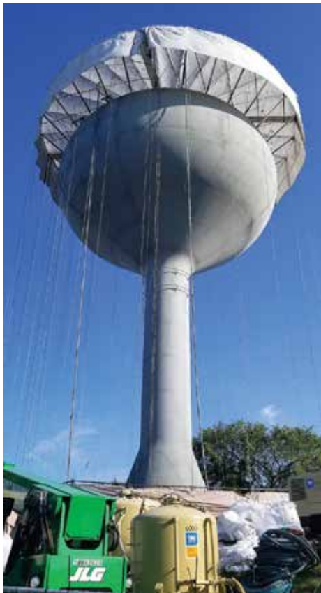
FIG. 4: El contratista de recubrimiento instaló un sistema de contención completo alrededor de la torre para evitar que el polvo, los escombros y el exceso de pintura se escapen del lugar de trabajo durante los trabajos de restauración.
