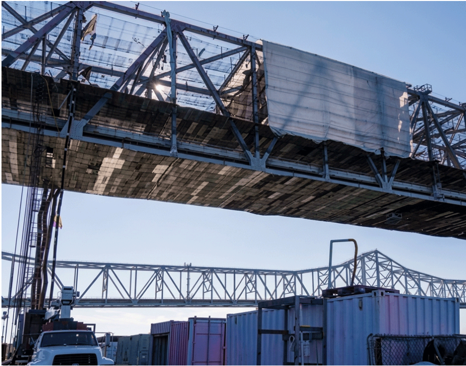
En la planificación de la pintura de puentes se debe tener en cuenta la posible necesidad de estructuras de acceso y contención.
