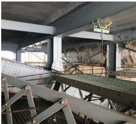
Se debe prestar especial atención al recubrimiento de las zonas de difícil acceso.
