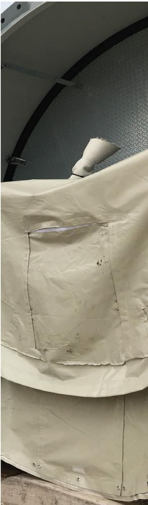
FOTO: CORTESÍA DE KTA-TATOR, INC. / FIG. 1: Se retiraron las lonas del borde de las secciones de la torre para exponer el recubrimiento.
