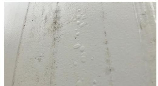
FOTO: CORTESÍA DE KTA-TATOR, INC. / FIG. 2: Ampollas claramente visibles en el recubrimiento cerca del borde del recubrimiento retirado.
