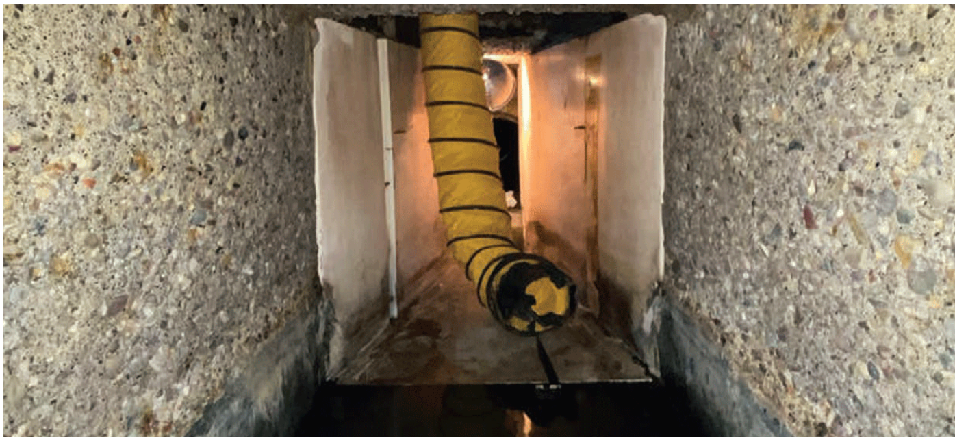
FIG. 1: Una estructura de canalización de 10 pulgadas (25.4cm) que contenía equipos de control de caudal, junto con 55 pies (16.76m) de tubería asociada, presentaba sus propios retos que requerirían una solución más allá de la rehabilitación con tubería curada in situ.
