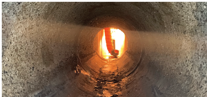
FIG. 2: La preparación de los 55 pies (16.76m) de tubería y de las estructuras del canal y de la boca de acceso implicó el lavado a presión y varios métodos de reparación del hormigón.
