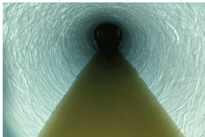
FIG. 3: La tubería recubierta de epóxico totalmente curada estaba lista para volver al servicio después de pasar las pruebas finales de calidad y la inspección, incluidas las pruebas de holidays.
