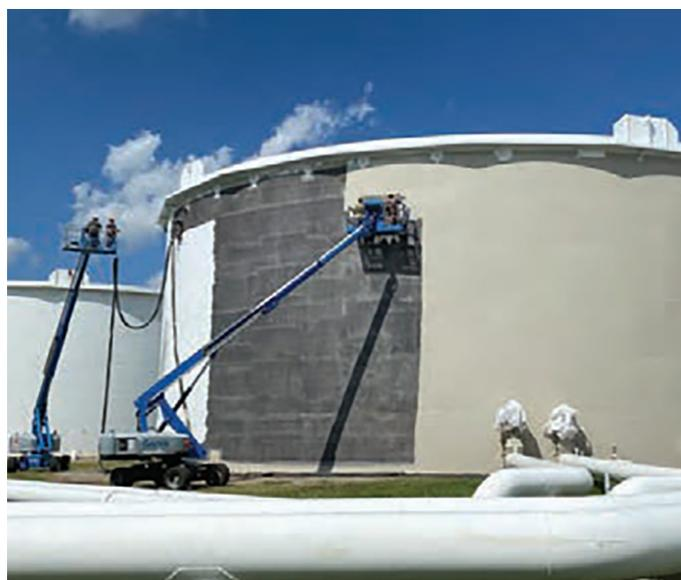
FIG. 4: Los equipos automatizados de preparación de superficies por arrastre pueden permitir la aplicación de recubrimientos siguiendo su trayectoria.
