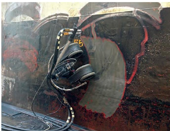
FIG. 2: Esta unidad de arrastre magnética realiza un granallado en el casco de un buque.
