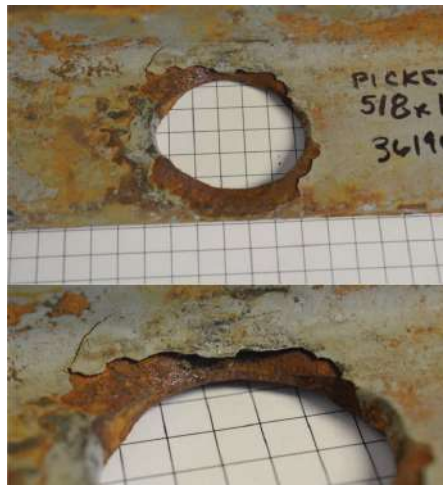
Fig. 8: Orificio ranurado para perno en la Muestra 2. La imagen inferior muestra el ataque suave a lo ancho de la ranura. Se observan grietas en el recubrimiento y el ataque está socavado por debajo. El contorno rojo en la imagen superior muestra las dimensiones originales aproximadas del orificio para perno.
