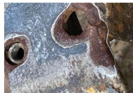
Fig. 14: Clara evidencia de corrosión galvánica del acero al carbono en los orificios de los pernos donde los sujetadores de acero inoxidable conectaban las cuchillas raspadoras a los brazos del rastrillo. Estos orificios eran redondos antes de que las pérdidas por corrosión en los bordes los ensancharan.
